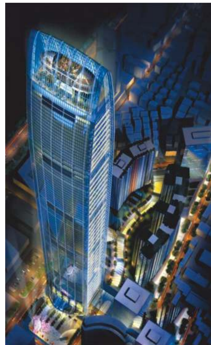
深圳京基金融中心 全球第八、深圳第一高楼、100层；DN15-DN500采用卡压式，DN65以上采用承插焊接式不锈钢管路系统。
