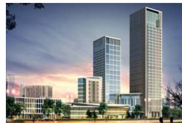
天津大岛商业广场综合体工程 天津市河西区梅江片区唯一一家商业综合体；冷水管道路材料采用304，热水管道材料采用316L。
