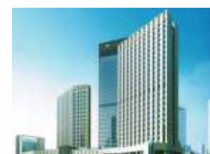
南通绿洲国际大酒店 冷热水管道系统
