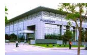
富士康 循环水及供水管道系统
