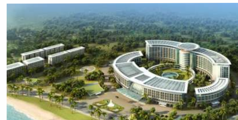
解放军301医院海南分院 解放军规模最大的综合性医院；涵盖冷水、热水、医疗用水和净化系统管道等。
