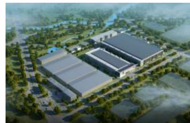
华星光电 深圳市政府建市以来单笔投资额最大的项目；废水系统及供水系统均采用焊接连接方式。
